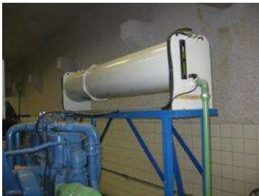
Foto 9: Detalhe de tanque de fluido de refrigeração do circuito fechado junto a um motor.
