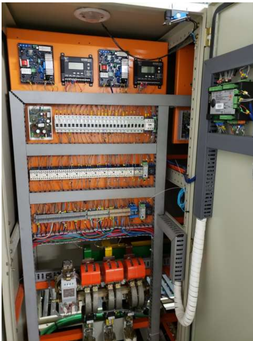
Foto 40: Detalhe da USCA, com controladores ComAp IG-NT na porta, controladores de velocidade e AVRs na parte superior, carregador de baterias, disjuntores e contadoras no meio, e contatora de potência e transformadores de corrente na parte inferior.
