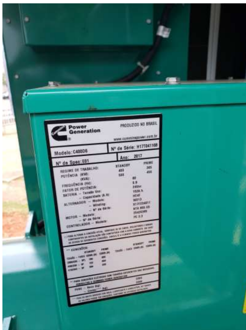
Foto 50: Placa do grupo motor-gerador, Cummins C400D6.
