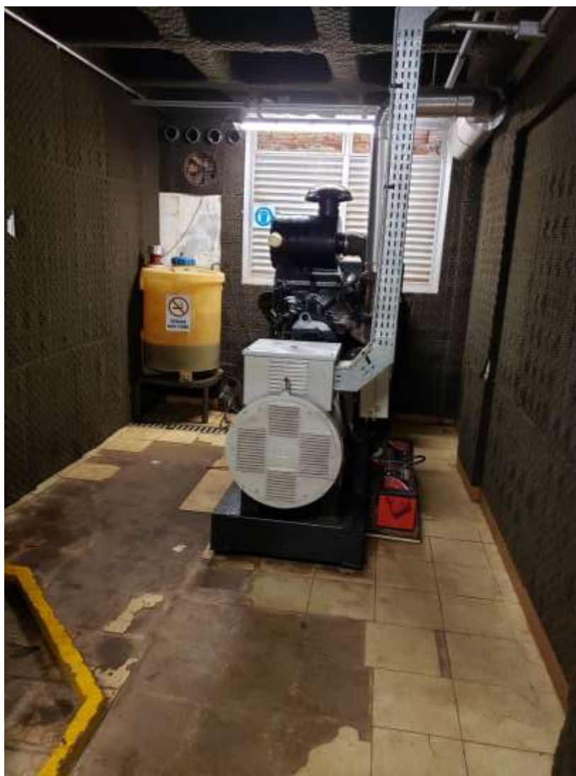
Foto 53: Visão geral do grupo motor-gerador, com tanque de combustível ao fundo.
