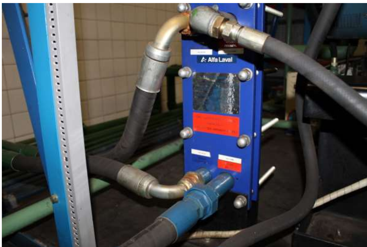
Foto 4: Trocador de calor da linha de combustível. Trata-se de trocador de calor de placas Alfa Laval M3-FG, com 11 placas e volume de 1 litro.
