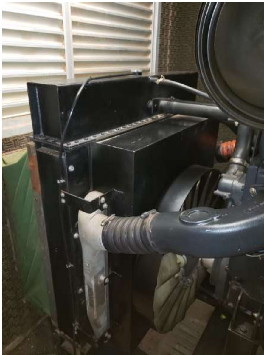
Foto 61: Radiador e ventoinha de arrefecimento do grupo motor-gerador.
