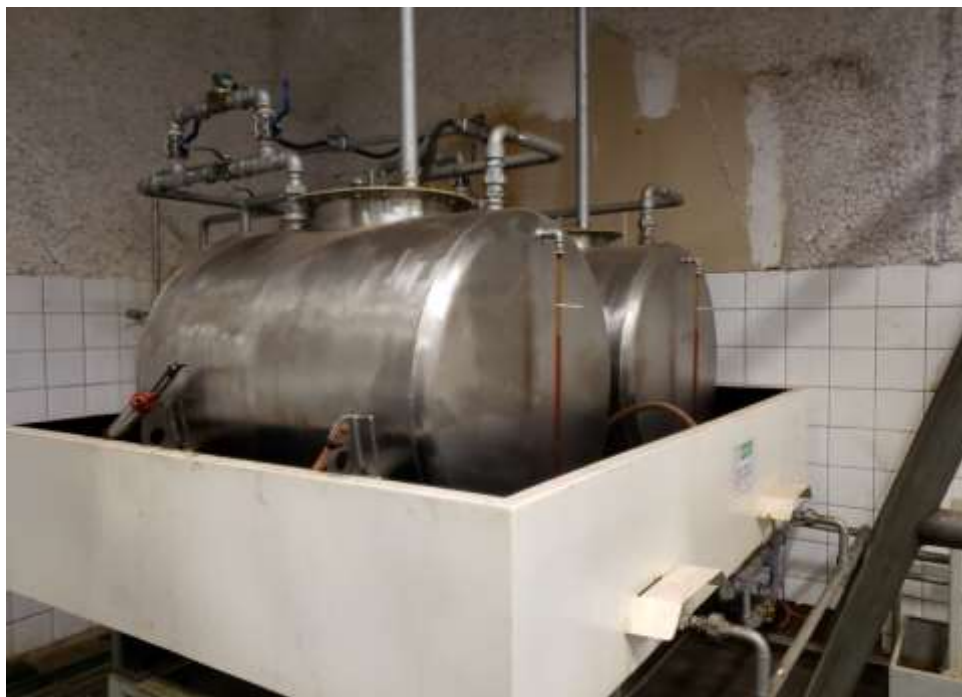
Foto 16: Detalhe dos dois tanques secundários de combustível localizados ao lado dos grupos geradores.
