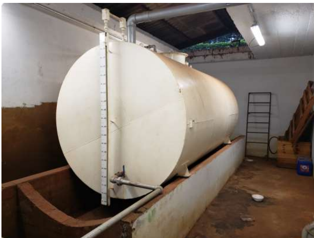
Foto 19: Tanque primário de combustível, com capacidade de 10.000 litros.
