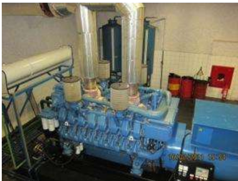
Foto 3: Vista aérea do motor, gerador, totem de automação, reservatório de fluido de refrigeração (branco, horizontal) e dutos do sistema de exaustão de gases. Foto tirada do Grupo Motor-Gerador 1 (atualmente desativado); o Grupo Motor-Gerador 2 é idêntico ao Grupo Motor-Gerador 1.
