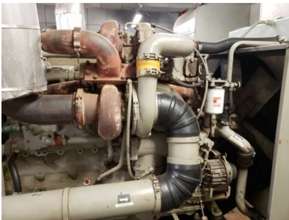
Foto 34: Detalhe do equipamento, com o turbo-compressor, dutos de admissão de ar, radiador, filtro de água, ventoinha e alternador.
