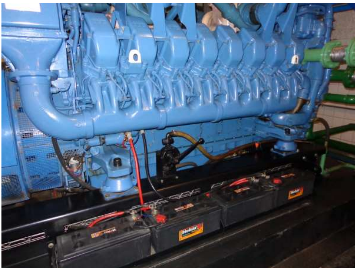
Foto 6: Conjunto de baterias de partida de um motor diesel (quatro baterias de 12 V, formando dois conjuntos de 24V em paralelo).
