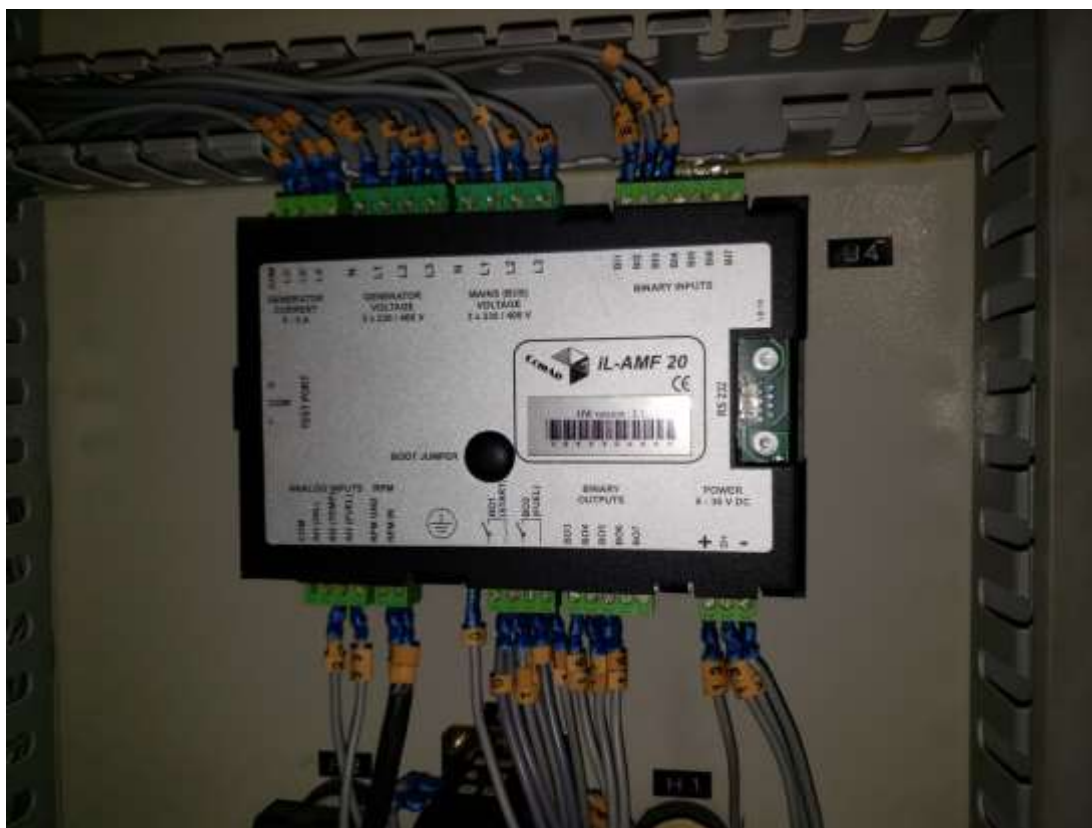
Foto 66: Controlador do grupo motor-gerador (ComAp IL-AMF-20).
