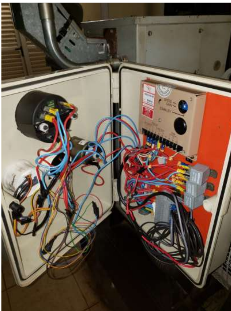
Foto 64: Parte interna do painel de instrumentos do grupo motor-gerador, com relés e controlador de velocidade.
