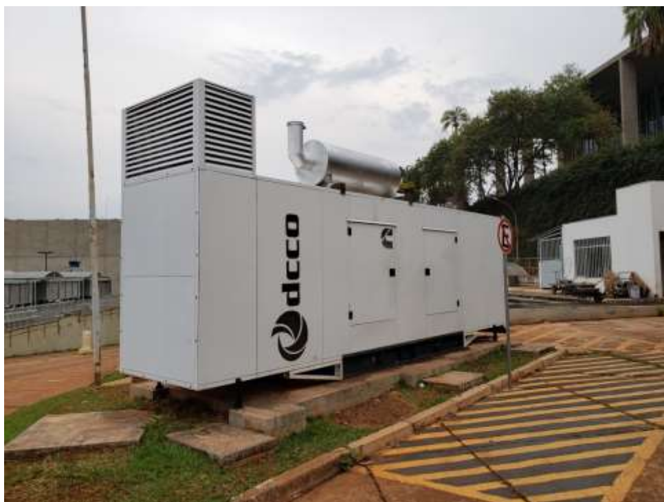
Foto 42: Detalhe da carenagem do grupo motor-gerador do Ramal Y do Prodasen, localizado na parte externa da edificação.
