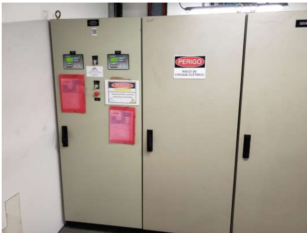
Foto 39: Detalhe do painel da USCA, local onde estão instalados os controladores dos grupos motores-geradores, o barramento de paralelismo, carregador de baterias, controlador de velocidade e AVR.
