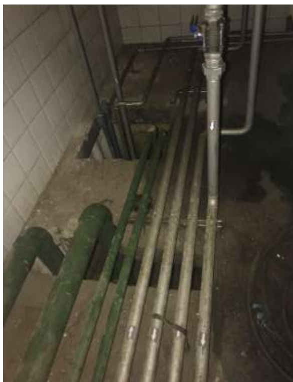
Foto 17: Detalhe das linhas de combustível (alimentação e retorno para cada um dos grupos geradores, em cinza).
