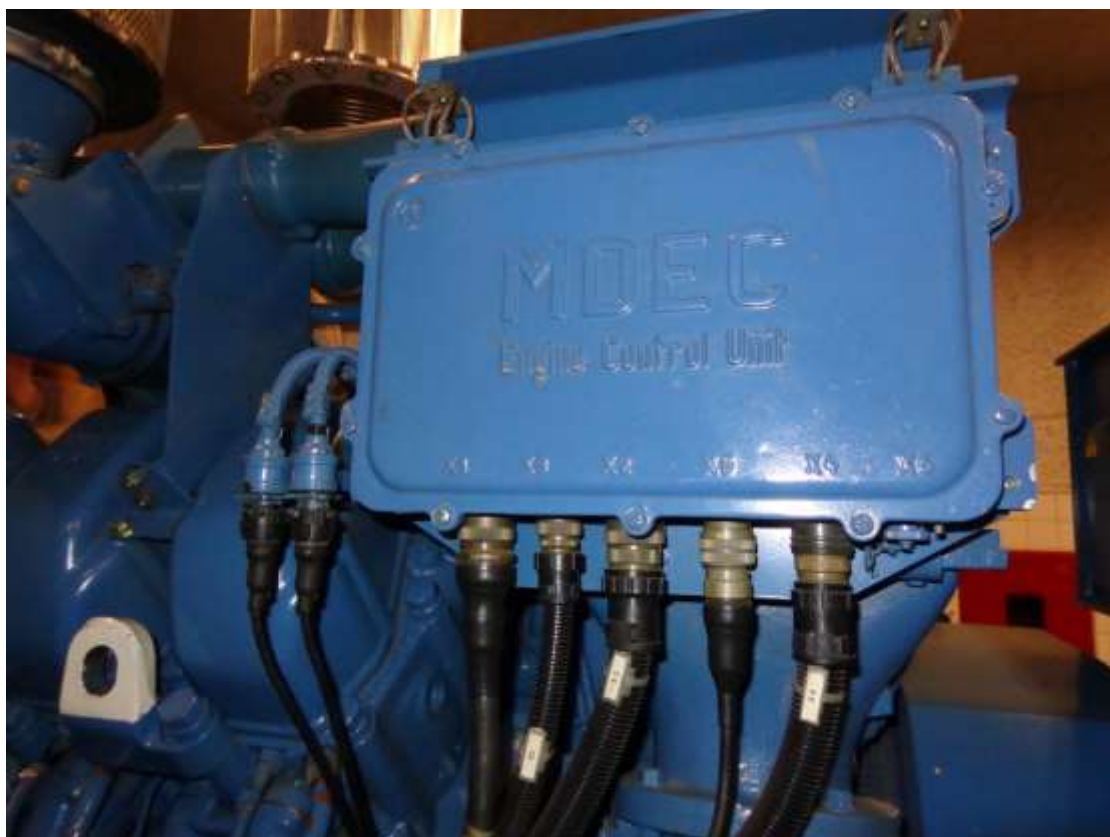
Foto 11: Módulo eletrônico de controle do motor diesel MTU (MDEC) e cabecamentos.
