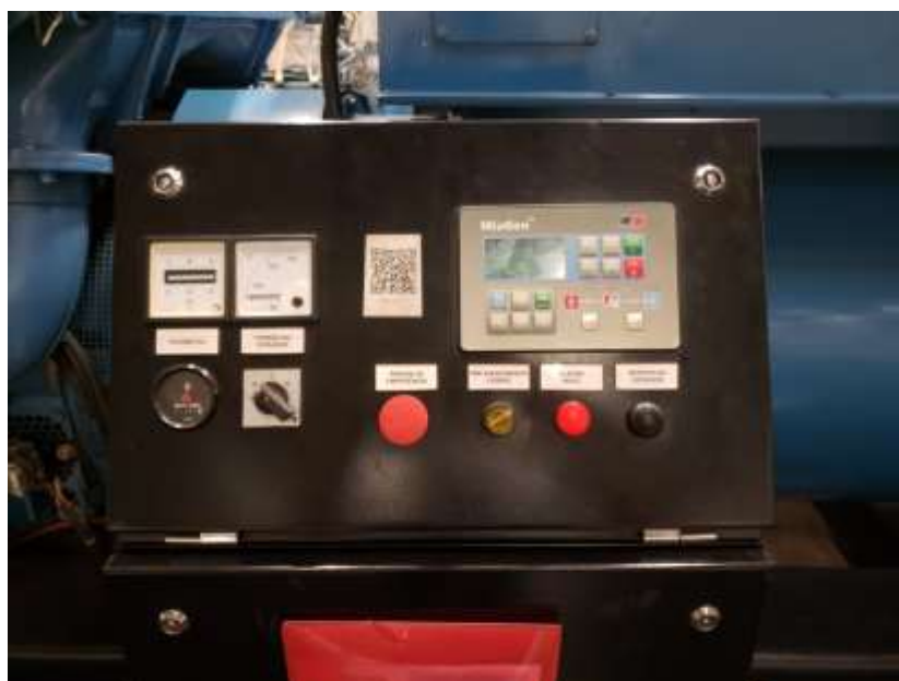
Foto 13: Totem de automação localizado ao lado do grupo gerador.
