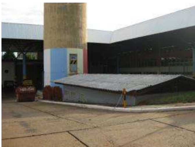
Foto 18: Em primeiro plano, a guarita que abriga o tanque principal de óleo diesel (10.000 litros), os tanques de diesel filtrado, o filtro prensa, a bomba de transferência de combustível, o quadro de comando e demais acessórios do sistema de combustível do Sistema de Geração de Energia Elétrica de Emergência Geral do Senado Federal.
