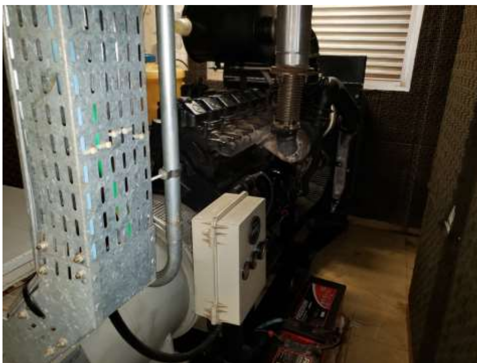
Foto 57: Vista lateral do grupo motor-gerador, com baterias e painel de instrumentos.
