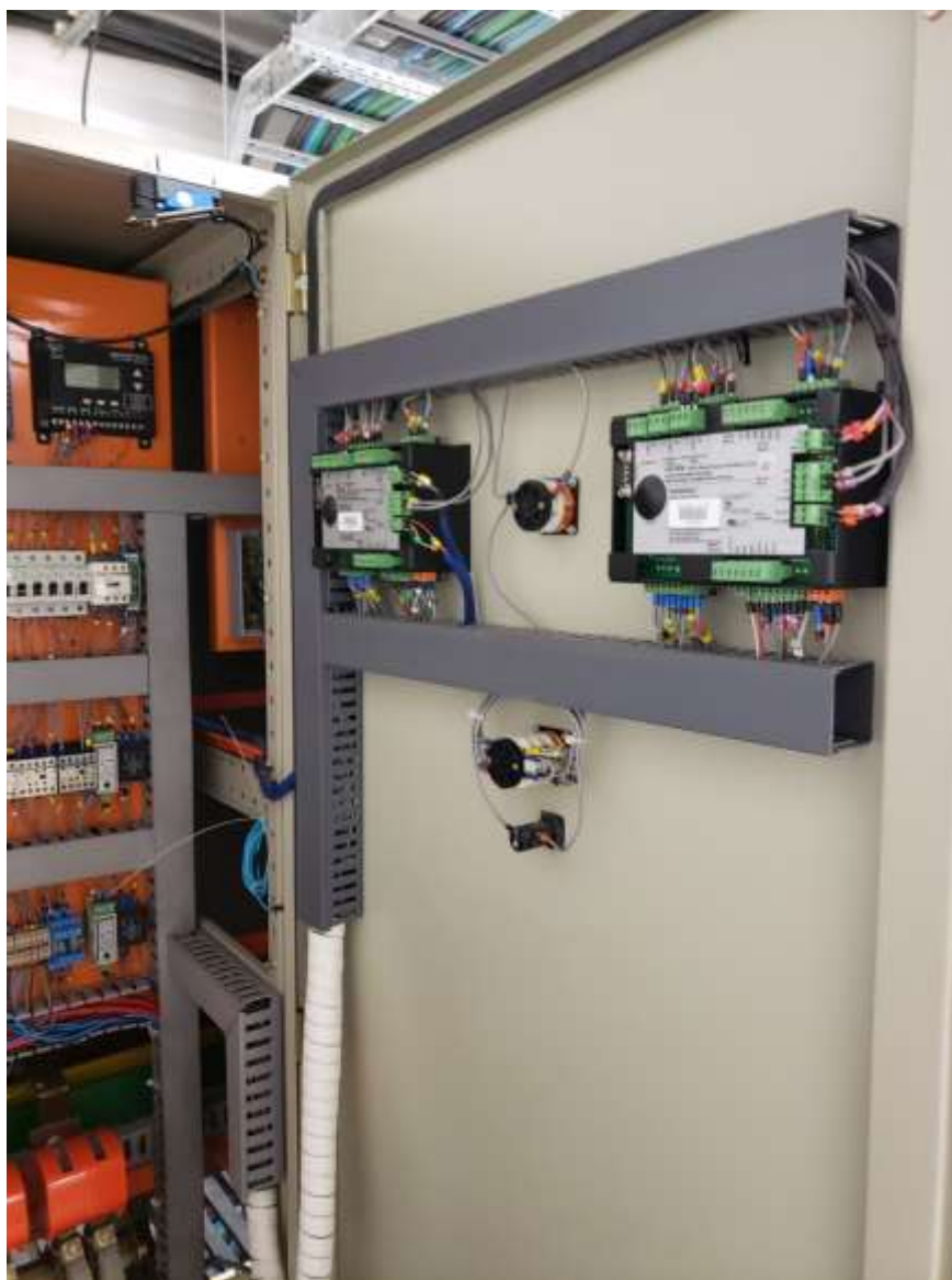
Foto 41: Detalhe da USCA, com controladores ComAp IG-NT na porta.
