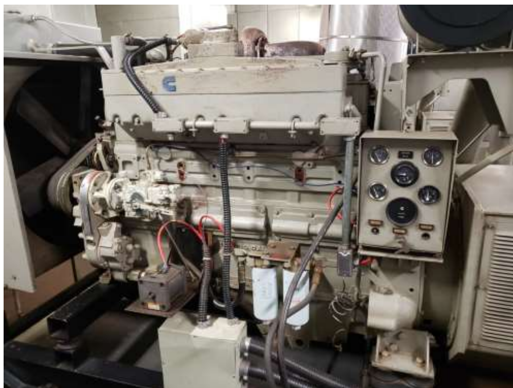
Foto 30: Detalhe do equipamento, com filtros de óleo, bomba injetora e atuador angular.
