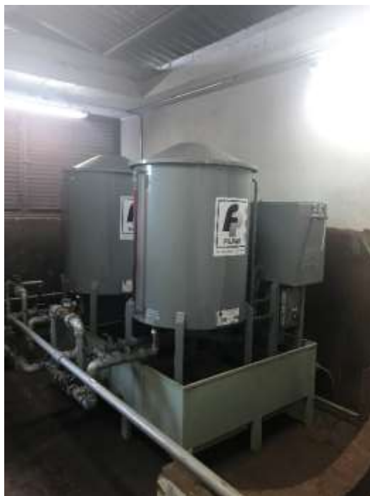
Foto 20: Interior da guarita mostrando filtro prensa, tanques de diesel filtrado e bomba de transferência de combustível.
