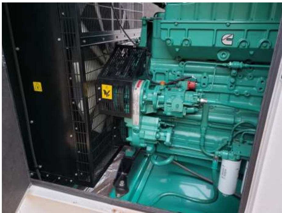
Foto 48: Detalhe do motor, com bomba injetora, filtros de combustível, radiador e ventoinha.
