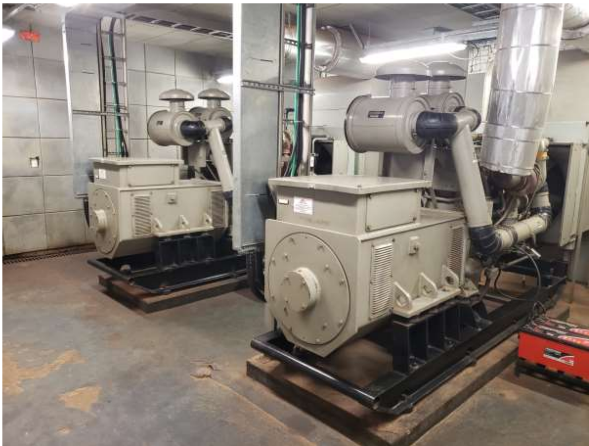
Foto 27: Visão geral do Sistema de Geração de Energia de Emergência do Prodase – Ramal X, formado por dois grupos motores-geradores operando em paralelo.
