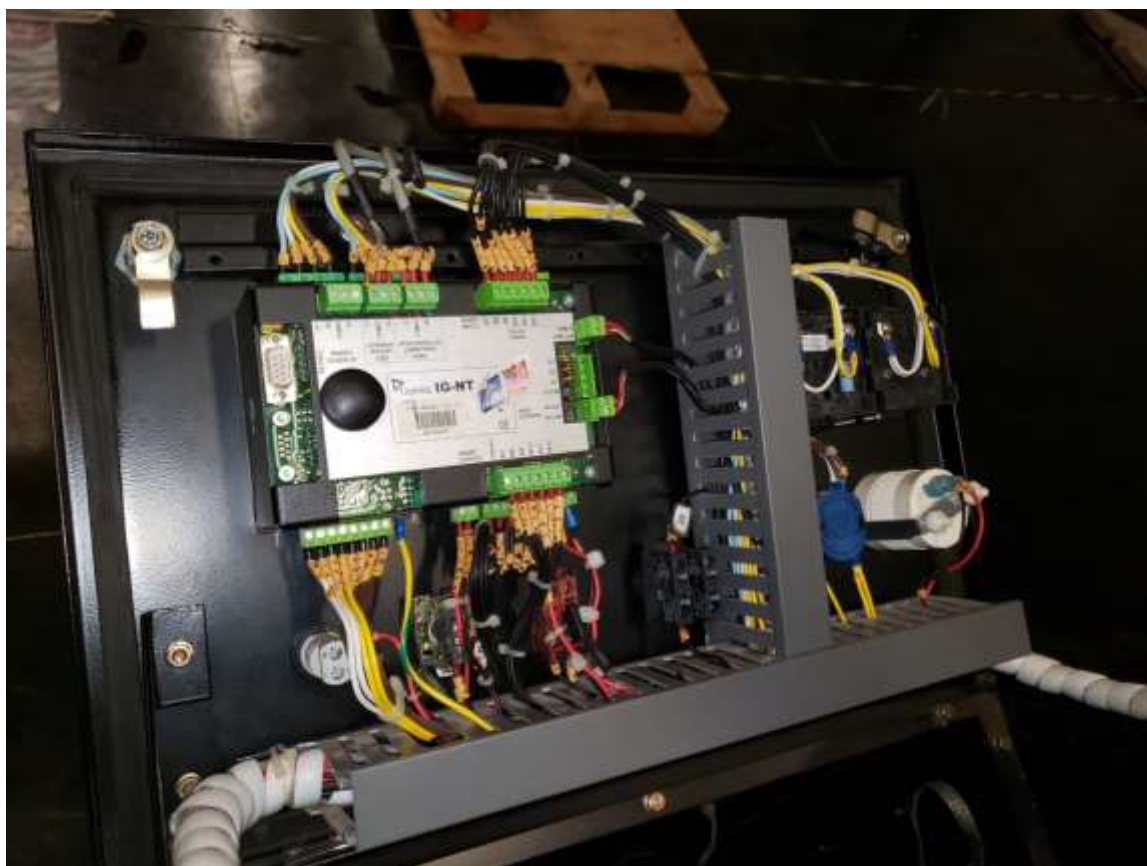
Foto 14: Vista interna do tótem de automação localizado ao lado do grupo gerador, com o controlador ComAp IG-NT.
