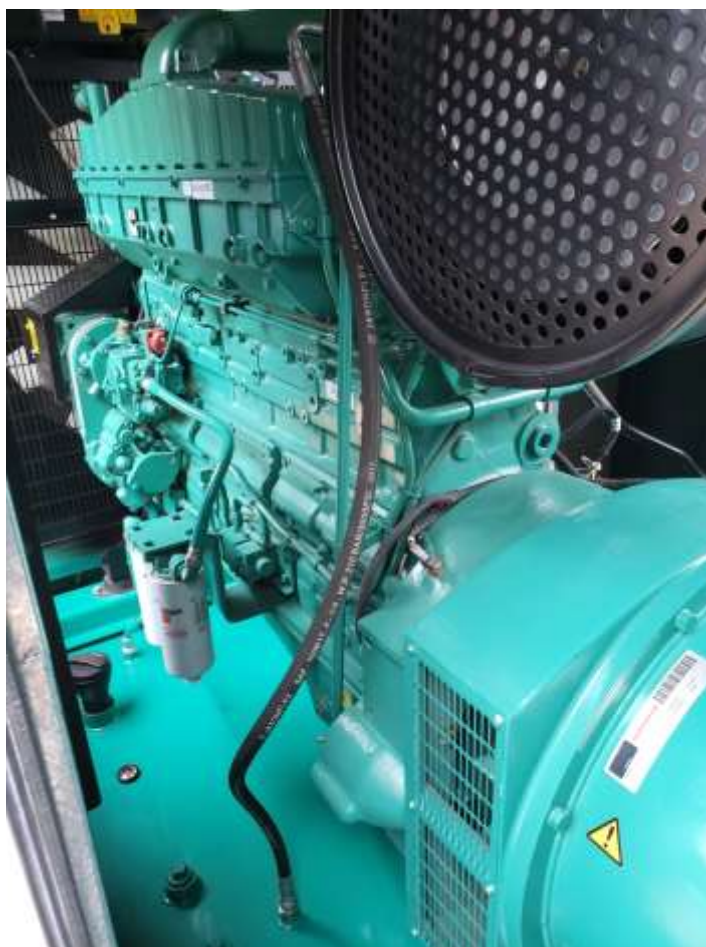
Foto 51: Detalhe do grupo motor-gerador. Tanque de combustível na base.
