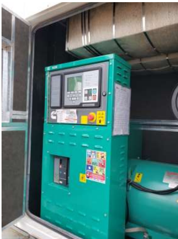
Foto 44: Detalhe do controlador do grupo motor-gerador. Trata-se de um Cummins Power Command 3.3.
