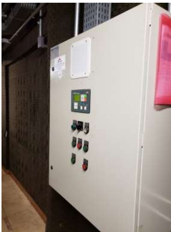
Foto 54: Visão geral do painel de comando e controlador do grupo motor-gerador.
