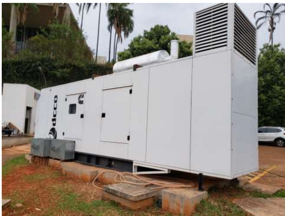
Foto 43: Detalhe da carenagem do grupo motor-gerador do Ramal Y do Prodasen, localizado na parte externa da edificação.
