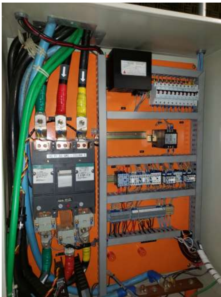
Foto 67: Visão geral da parte interna do painel de comando e controle do grupo motor-gerador.
