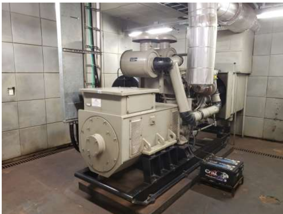
Foto 29: Detalhe do Grupo Motor-Gerador 2, idêntico ao Grupo Motor-Gerador 1.
