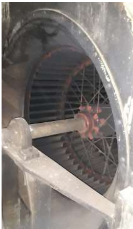
Foto 26: Detalhe do exaustor de fumaça.
