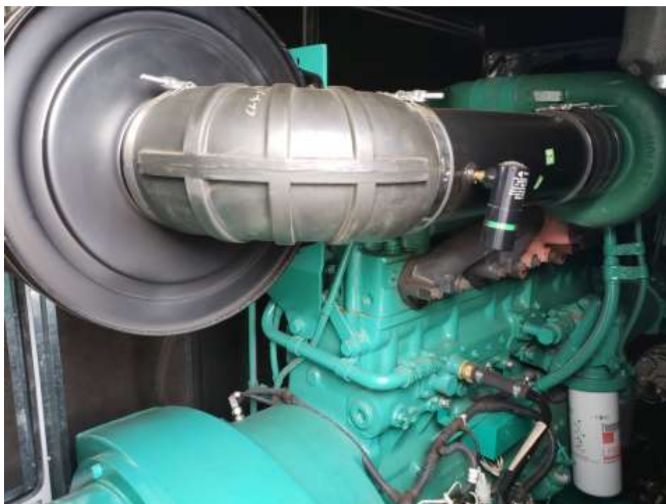
Foto 46: Visão geral do motor Cummins NTA 855 G5.
