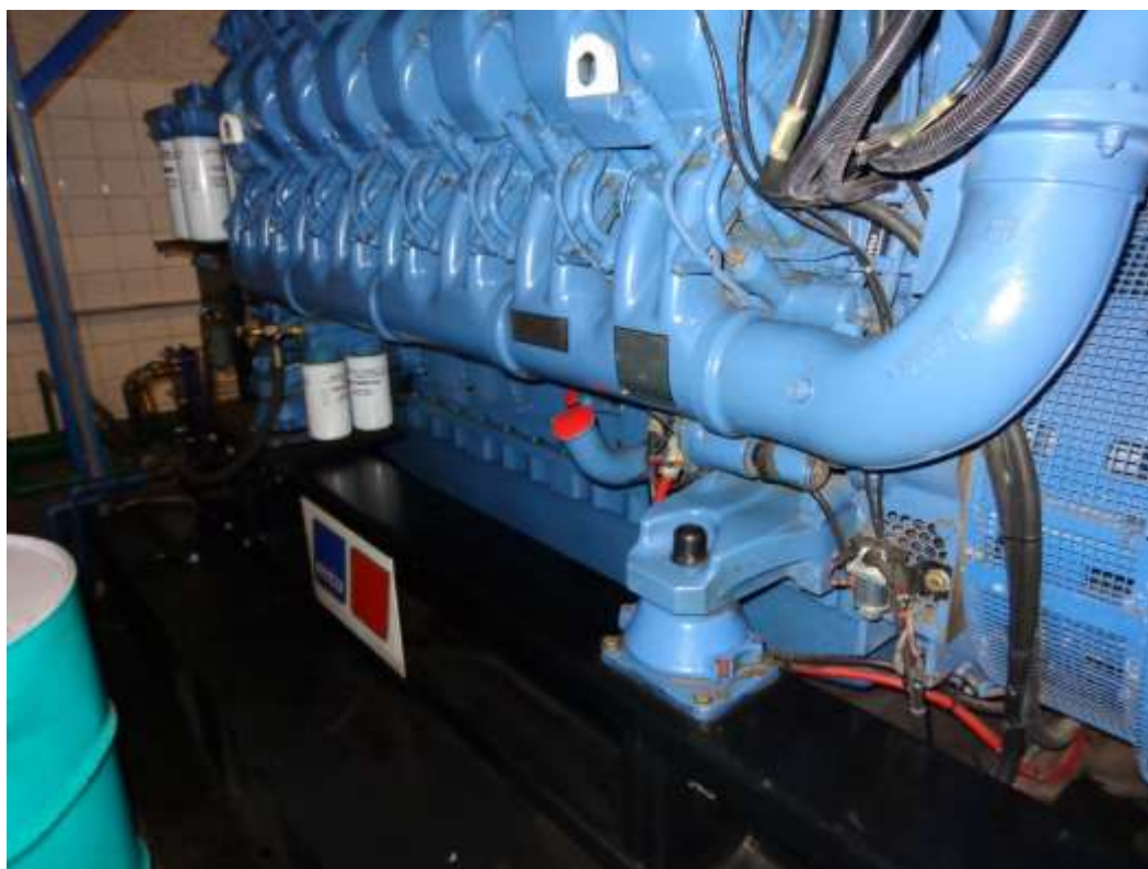
Foto 7: Detalhe do motor, com filtros de óleo e combustível ao fundo.
