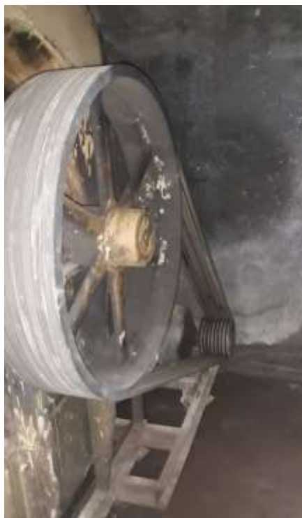
Foto 25: Detalhe do motor e do exaustor de fumaça.
