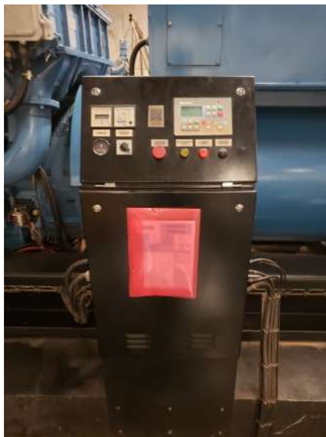
Foto 12: Totem de automação localizado ao lado do grupo gerador.
