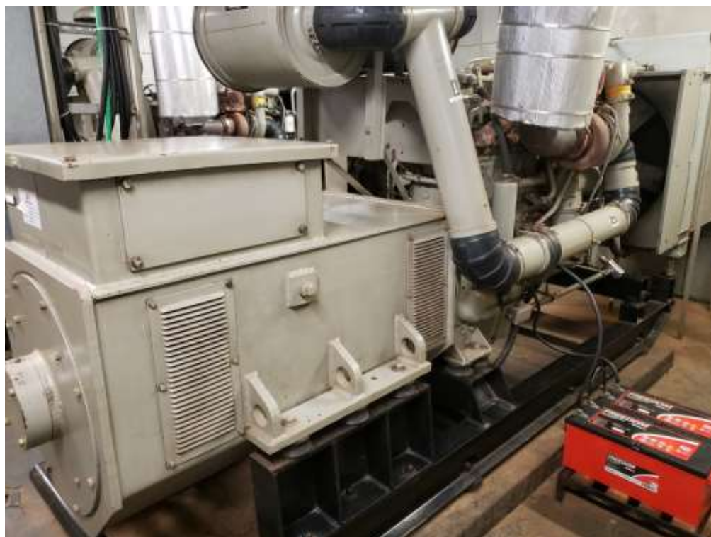
Foto 31: Detalhe do equipamento, com o gerador, baterias e tubulações de ar.
