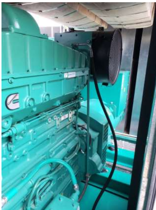
Foto 52: Detalhe do grupo motor-gerador.
