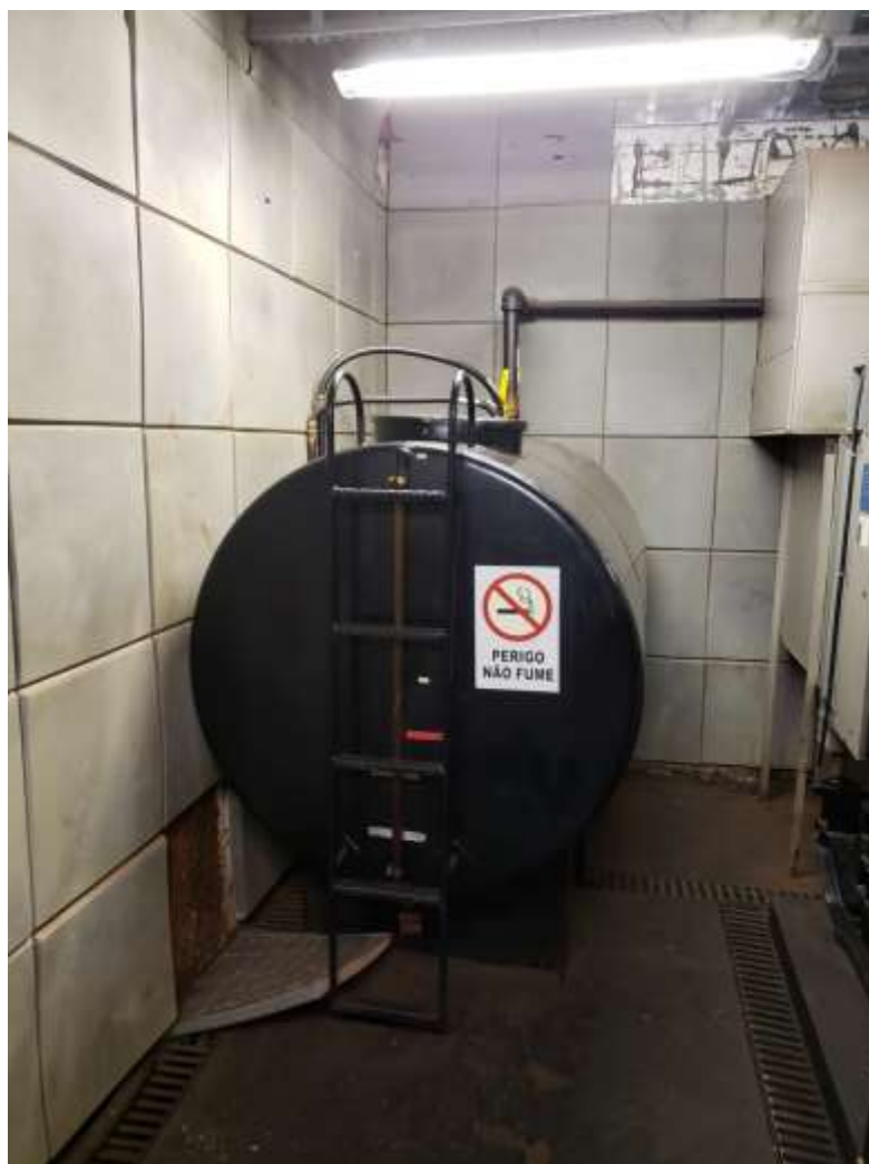
Foto 38: Detalhe do tanque de combustível, comum para os dois grupos motores-geradores.
