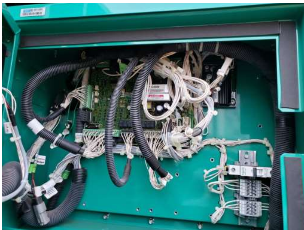
Foto 45: Detalhe da placa do controlador Cummins Power Command 3.3.
