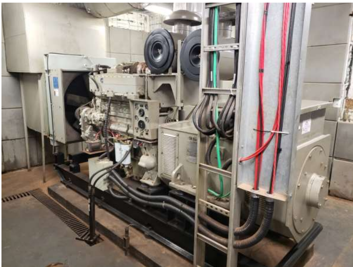
Foto 28: Detalhe do Grupo Motor-Gerador 1. Trata-se de um motor Cummins NTA 855 G e um gerador Siemens 1FC6354-4, com tensão de geração de 380V e potência de 350 kVA / 280 kW.
