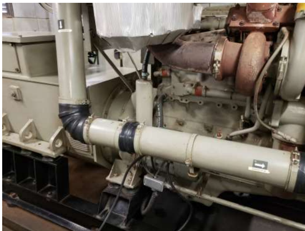
Foto 33: Detalhe do equipamento, com o turbo-compressor e dutos de admissão de ar.
