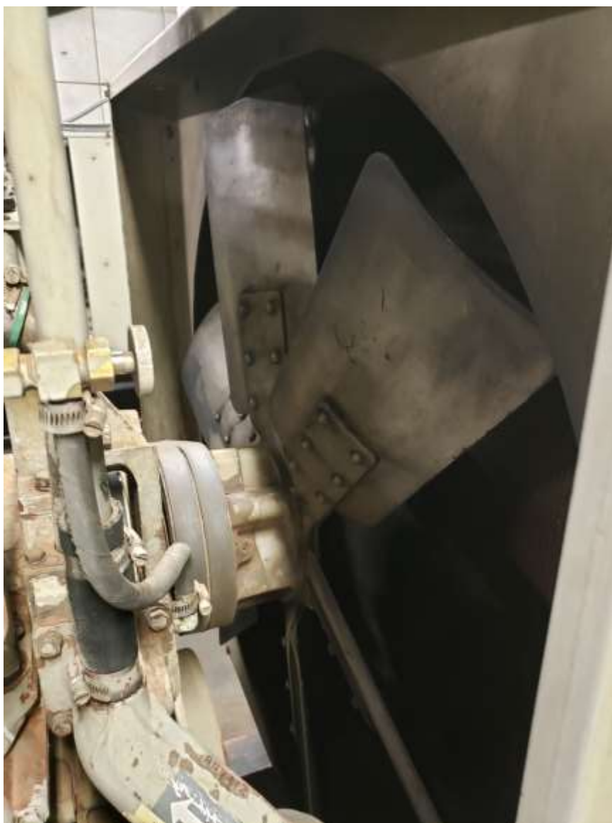
Foto 35: Detalhe do ventilador do sistema de arrefecimento.
