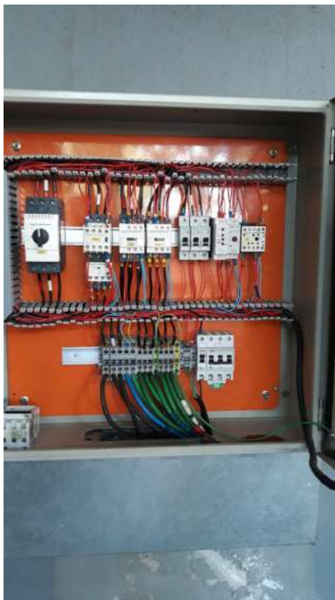
Foto 24: Quadro de comando do sistema de exaustão de fumaça.
