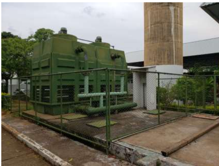
Foto 22: Torres de arrefecimento, parte do sistema de arrefecimento externo do grupo motor-gerador.
