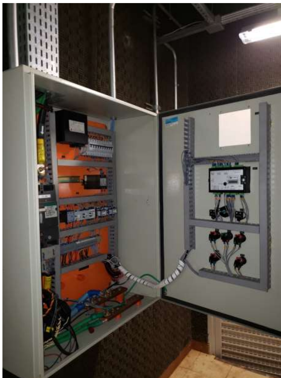
Foto 65: Painel de comando e controle do grupo motor-gerador.
