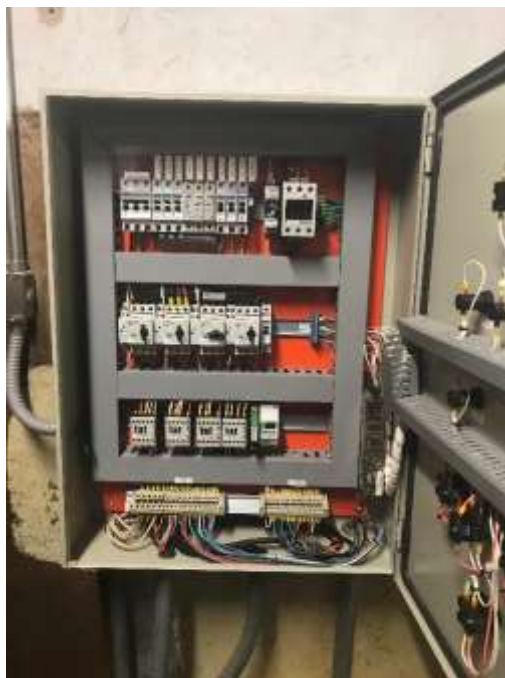
Foto 21: Quadro de comando do motor de bombeamento de combustível entre o tanque primário e tanques secundários.
