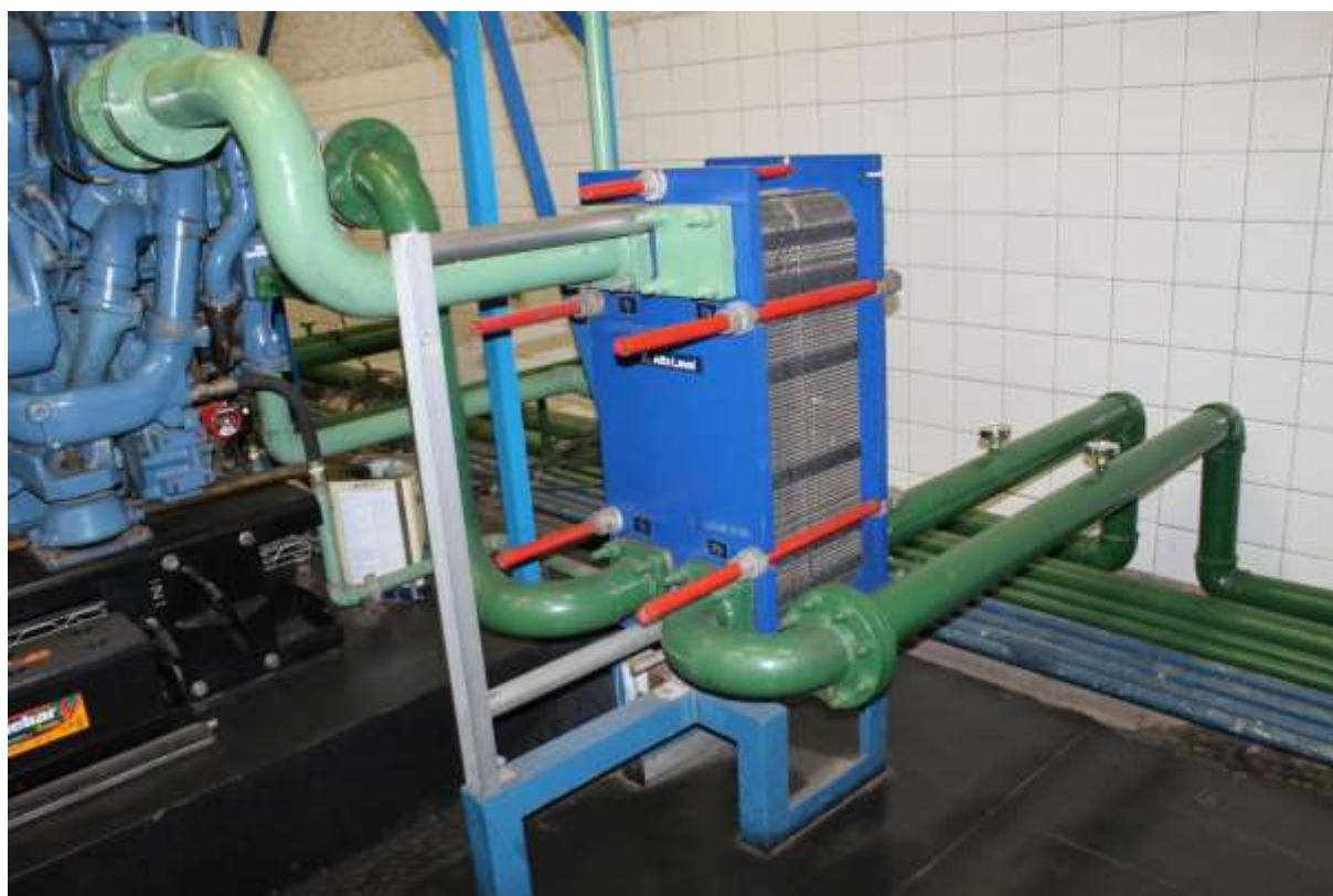
Foto 10: Detalhe do trocador de calor entre o circuito fechado de fluido de refrigeração de um motor e o circuito de água das torres de resfriamento externas. Trata-se de trocador de calor de placas Alfa Laval M10-MFM, com 74 placas e volume de 72 litros.
